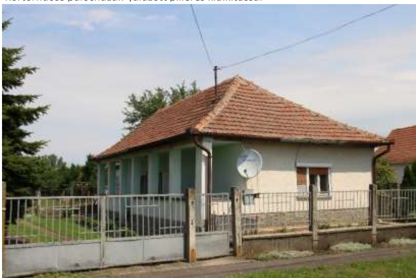
Körtornácos palóházak falazott pilléres kialakítással
