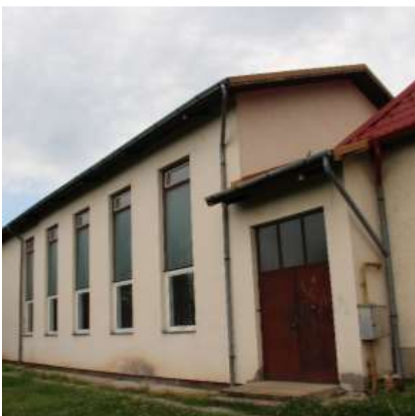
Iskola tornaterem bővítése
